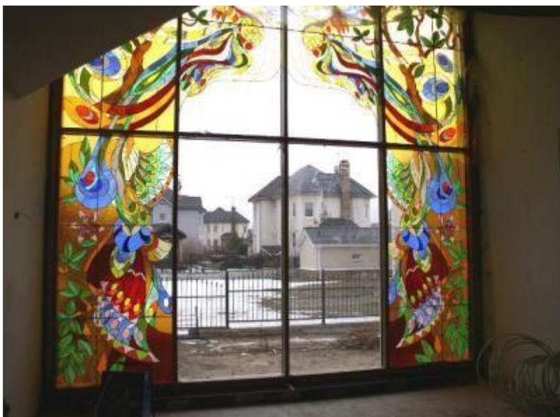
Протяженность витража может составлять несколько метров или равняться всей длине фасада. Назначение витражей и витрин - обеспечения естественной освещенности помещений и визуальной связи внутреннего пространства с внешним.
