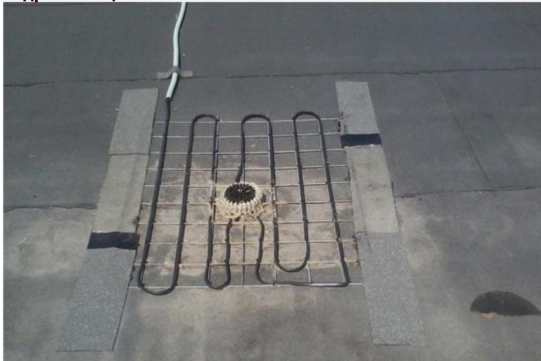
Монтаж и обогрев воронки
